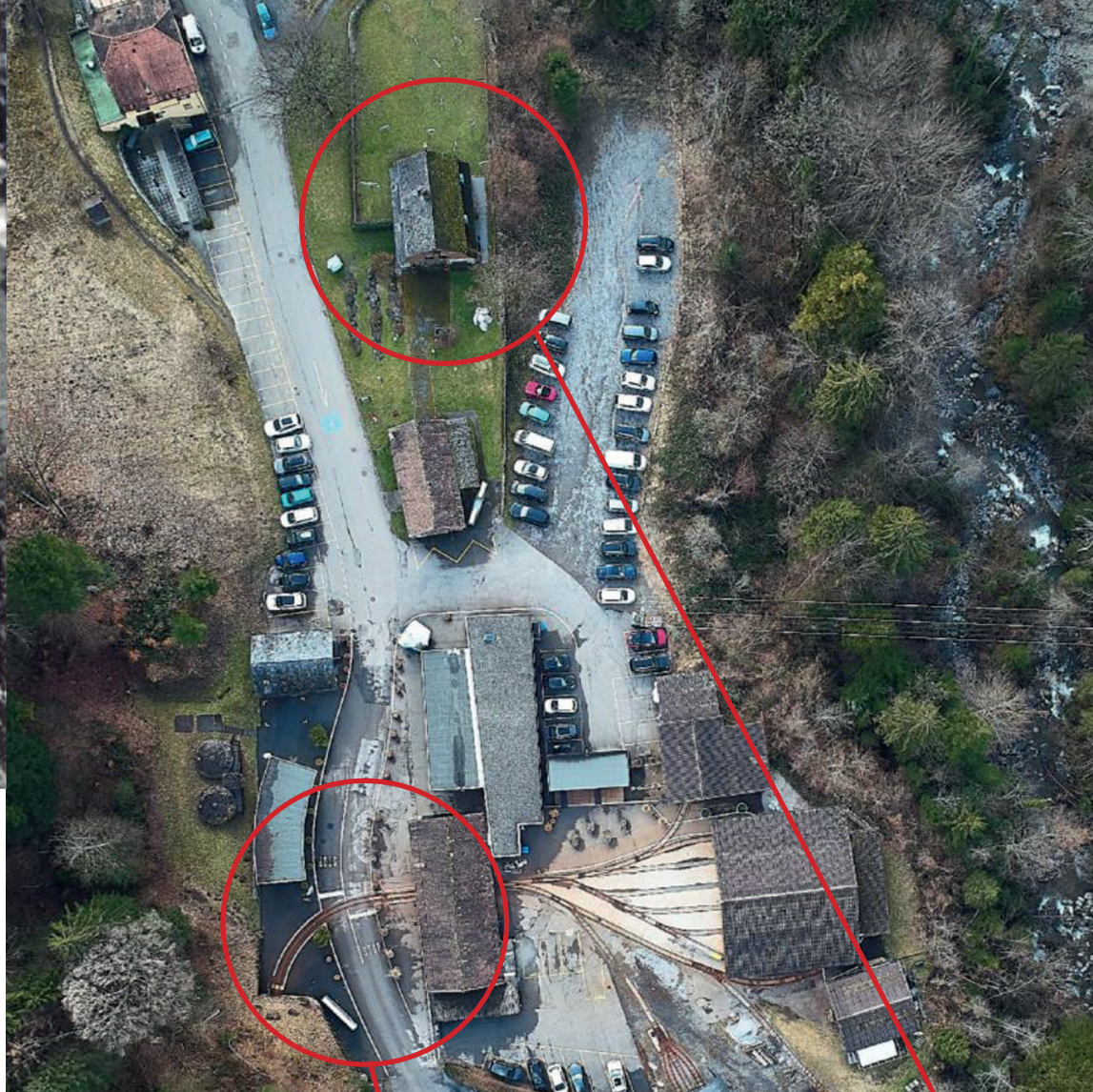
Vue aérienne du site des Mines avec le Chalet Bernois et l'entrée du Train des Mineurs
